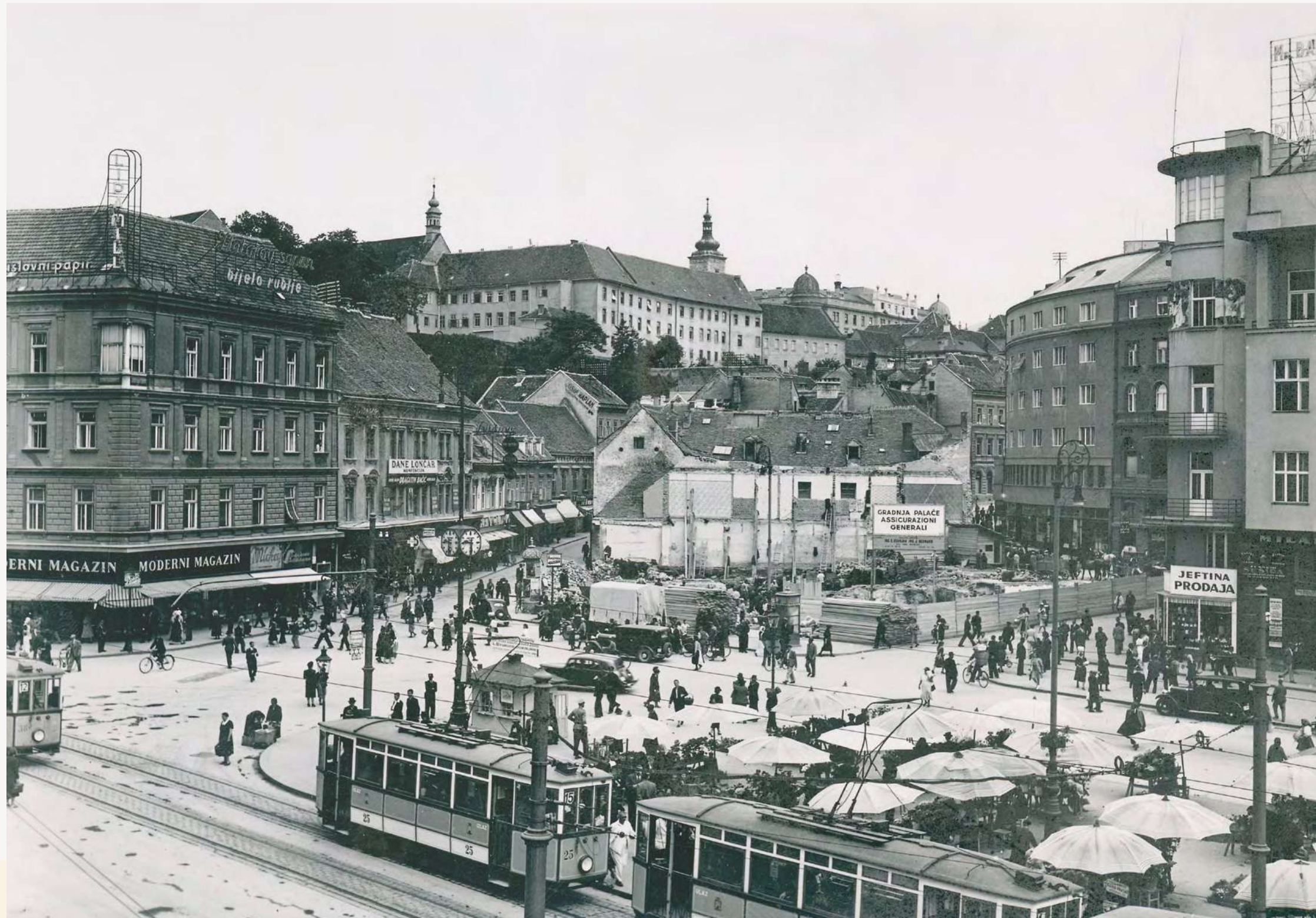
Gradnja palače Assicurazioni Generali na mjestu nekadašnje palače Pongratz. Zagreb. HR-DAZG-866, Zbirka fotografija, sig. 797.
